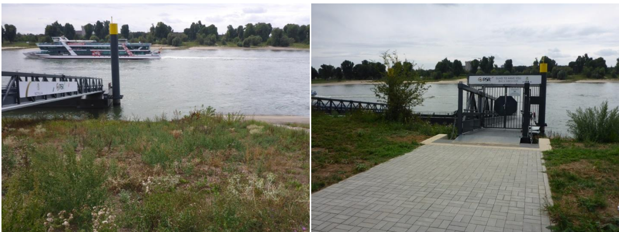
Abb. 4/10: Im Bereich des Transektes Schnellenburg wurde ein neuer Schiffsanleger errichtet. Fotos: M. Stevens, 28.08.2020.
